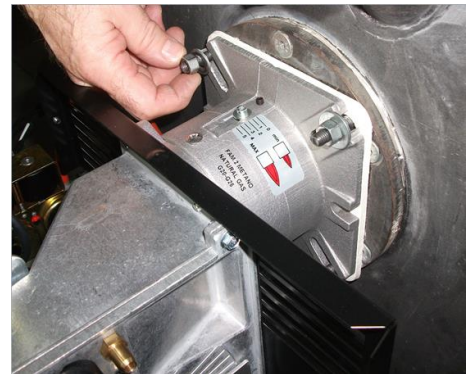
6) Зафиксировать горелки на котел;
