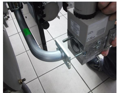
9) установить электроклапан на Труба ГАЗОВОЙ рампы;
