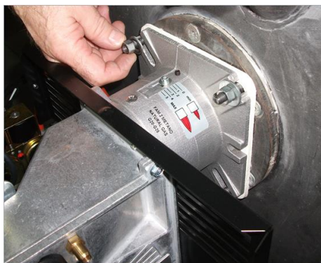
7) Зафиксировать горелки на котел;
