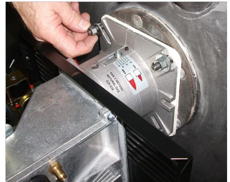
6) Зафиксировать горелки на котел;
