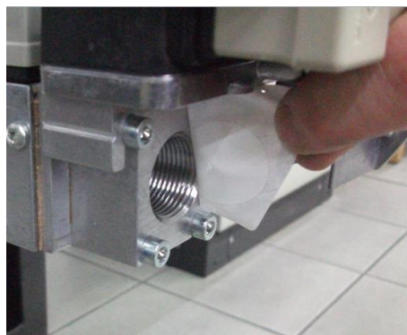
8) Снять заглушку из Труба ГАЗОВОЙ рампы;
